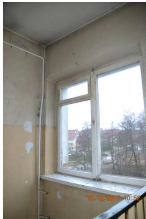
Fot.33 Druga klatka schodowa - stolarka okienna - drewniana, okna drewniane, zespolone. Stan techniczny okien - ZŁY.
