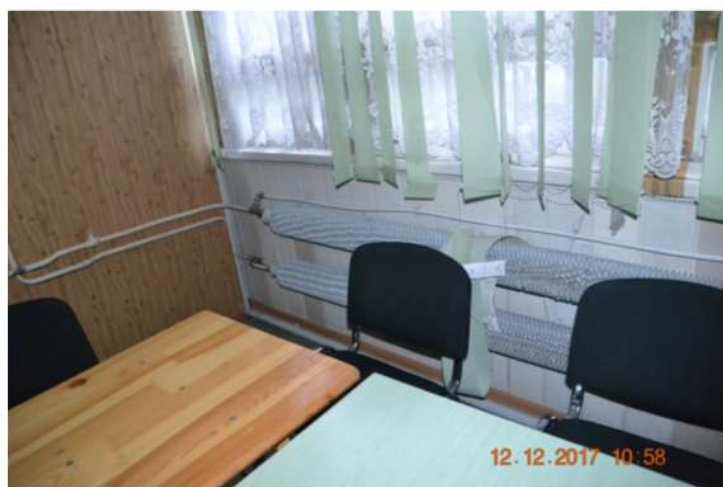
Fot.37 Swietlica - grzejniki tzw. - "fawery" Stan techniczny - DOBRY. Jeden grzejnik wymieniono na stalowy - "panelowy".
