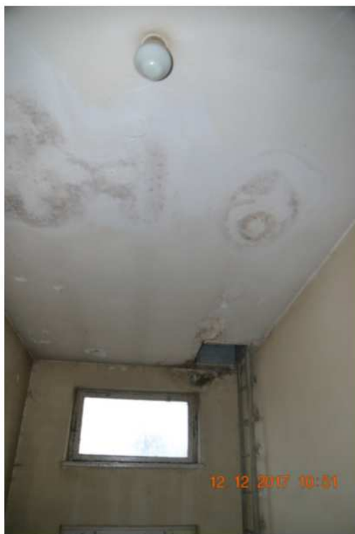
Fot.32 Druga klatka schodowa - stare przecieki z dachu.
